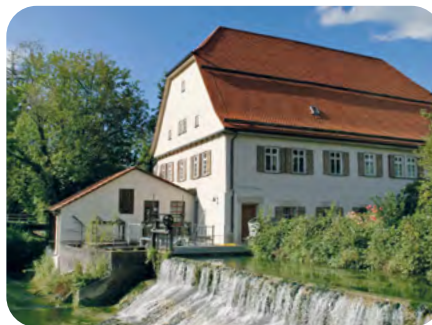
Das alte, liebevoll restaurierte Gebäude liegt direkt an der Echaz
