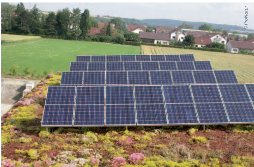
Das Dach der Firma ProNatur in Metzingen wurde mit einer Sedummischung extensiv begrünt und ist mit Photovoltaikmodulen ausgestattet.
