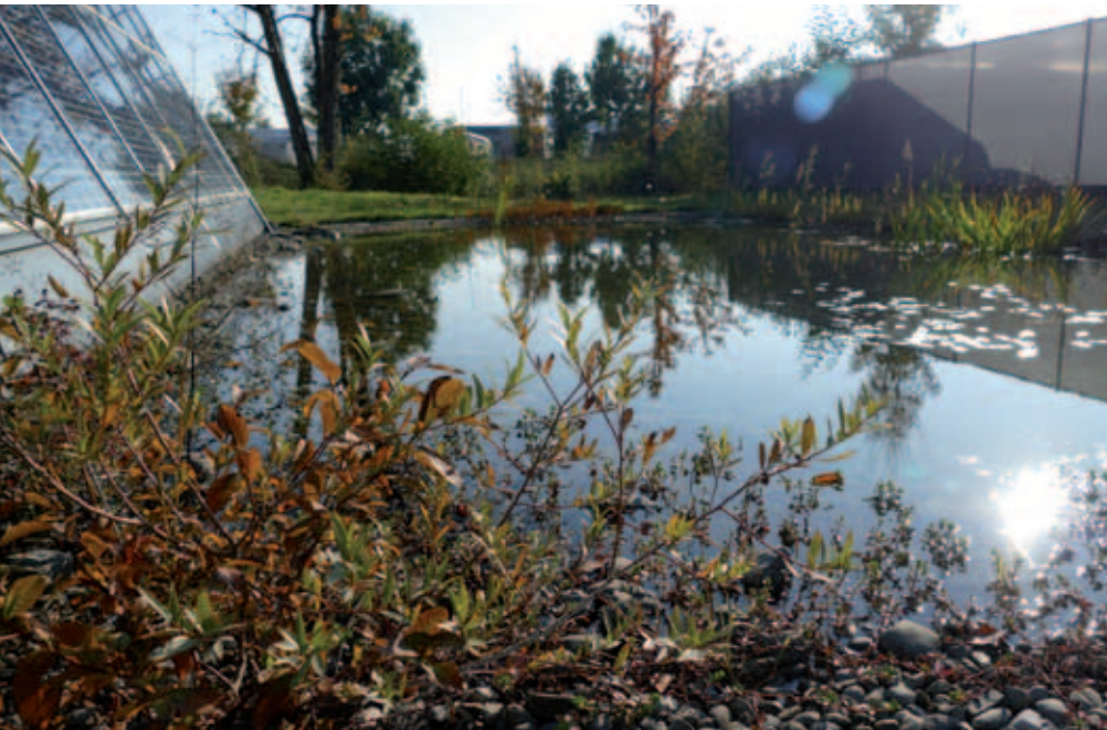
Das von den Solardächern der Firma RUOFF Energietechnik (Riederich) abfließende Wasser wird in Teichen gesammelt. Ein Teil wird in eine Zisterne geleitet und als Brauchwasser genutzt.
