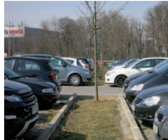
Begrünte Versickerungsmulde auf einem Firmenparkplatz, der von der Stadt Reutlingen angelegt wurde.
