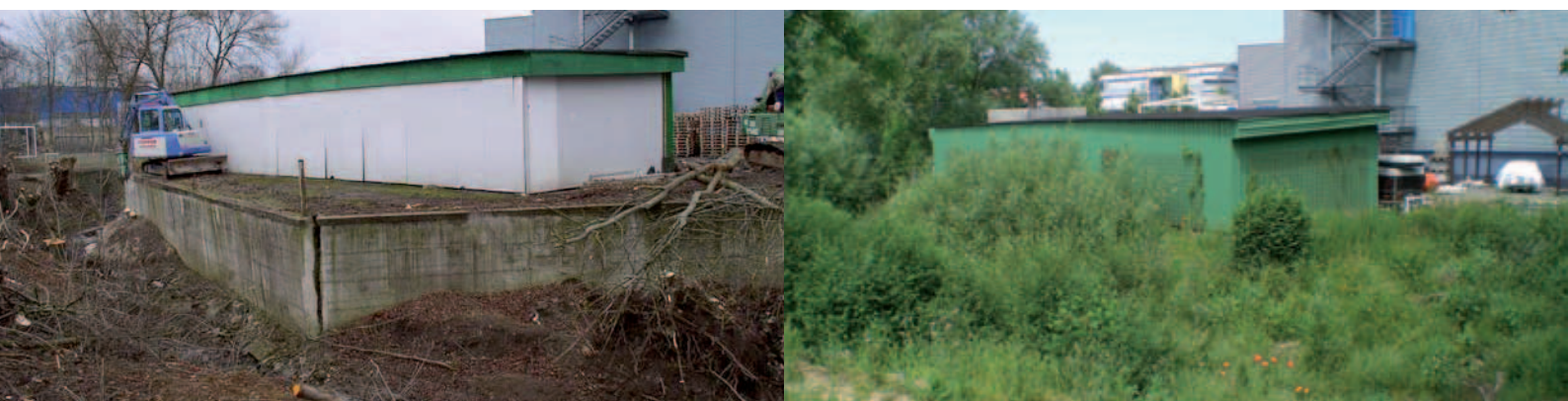
Am Waagenbach in Neuhausen a.d.F wurden anstelle einer Ufermauer Weidenbauweisen eingebracht, die das Ufer begrünen und langfristig sichern
